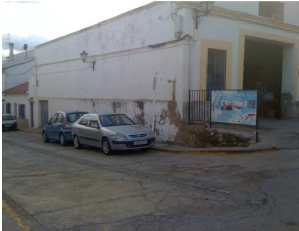
Richtung Ganterfly Appartements
